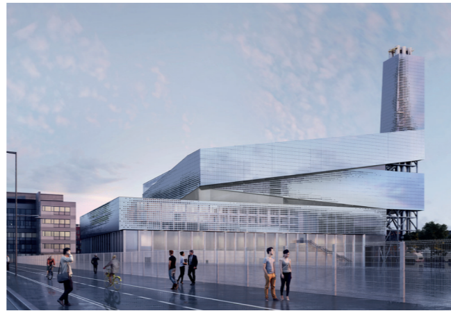
Centre de valorisation organique et énergétique, Ivry
