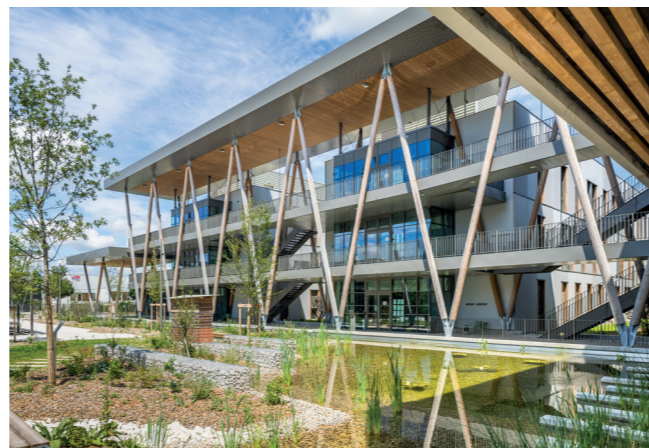
Campus Transfo, Centre de Formation RTE, Jonage
